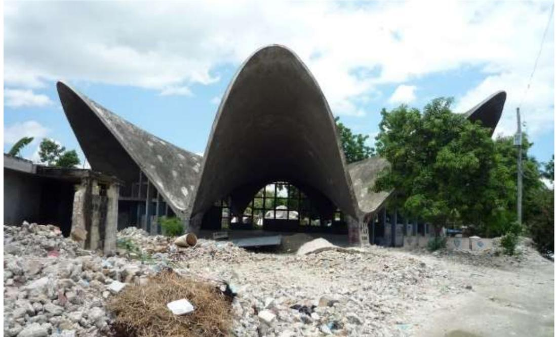
Brève description : Structure parabolôïde en voiles de béton mince typique de l'architecture de béton des années 1950-1960 à l'échelle internationale. Cette structure témoigne de la résonance de l'architecture moderne et du style international en Haïti, et démontre les nouvelles connaissances acquises par les ingénieurs haïtiens dans l'utilisation du béton armé.
