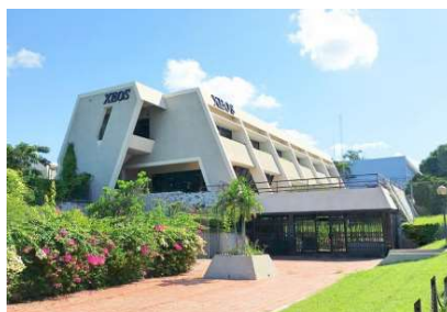
Figure 32 Bâtiment XEOX à Delmas TECINA S.A. 1984 Source : DocArchiMo F-011 Photo : TECINA S.A.
