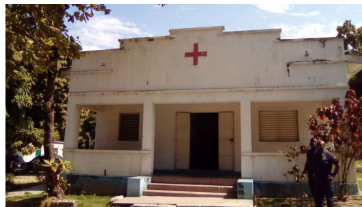
Photos des bâtiments annexes
